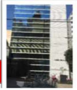
浜屋八秀ビルに到着 エレベーターで2階へ
